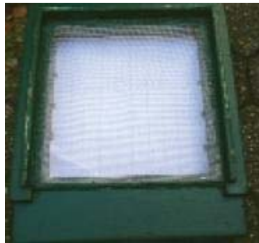
Detailaufnahme: Eck- Einleimung von unten betrachtet.
